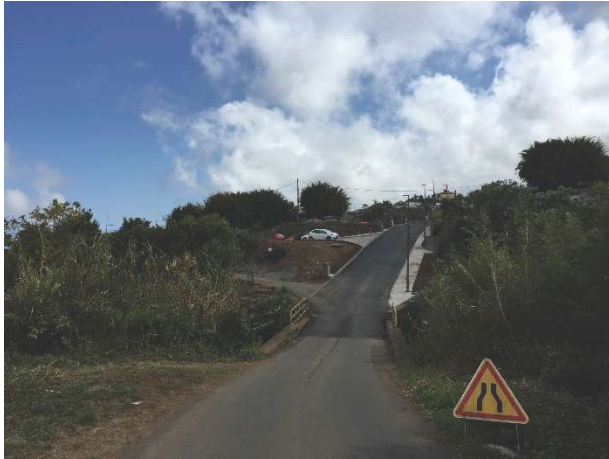
Vue 7 : Rue Henri Auber, radier de la ravine de la Souris Chaude, Vue vers l'opération RHI secteur château d'eau
