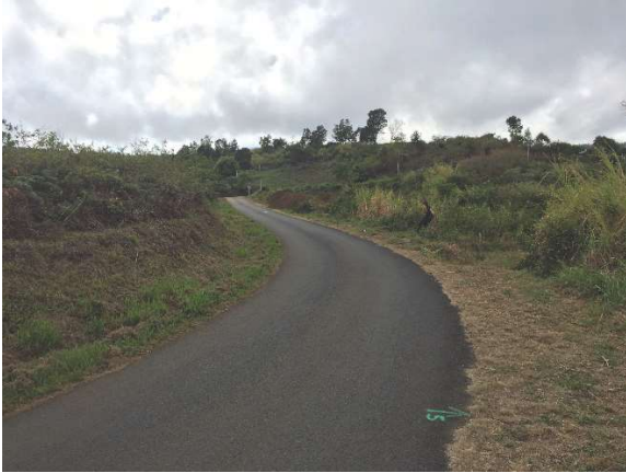
Vue 1 : Chemin de la Croix Bigat, vue vers l'est
