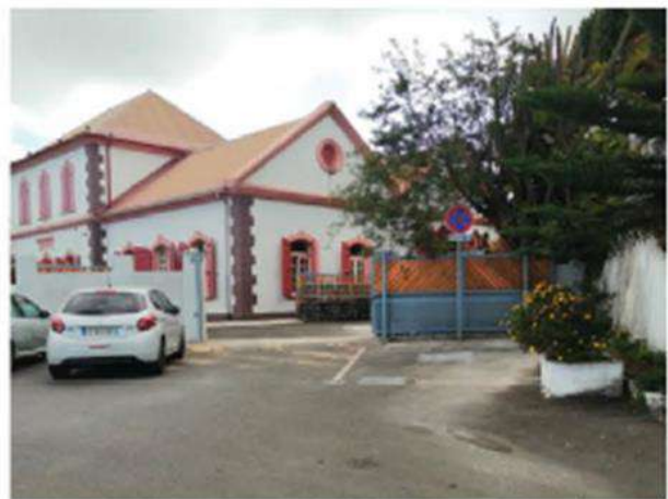
Accès voiture, fermé par un large portail
