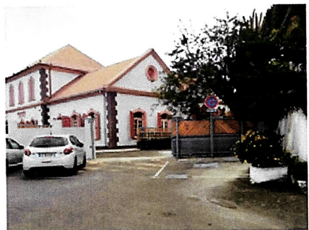
Accès voiture, fermé par un large portail
