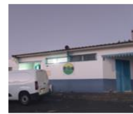
Locaux de l'APTF vieillissants et faiblement valorisés
